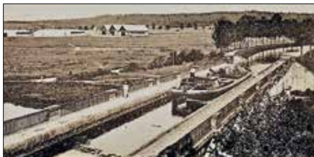
Le pont-canal de Golbey où le Canal de l'Est franchit la Moselle.
