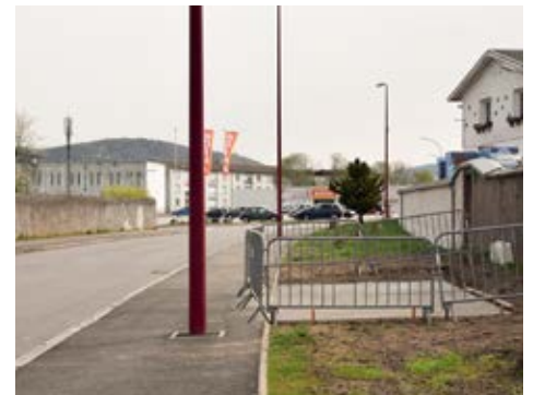
Les Services Techniques municipaux ont préparé, rue de la 1 ère Armée, l'emplacement qui accueille désormais le Point d'Apport Volontaire "verre", déplacé de la rue Jacques Mellez.
